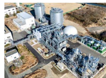
いわき市下水汚泥等利活用事業 (PFI事業)
