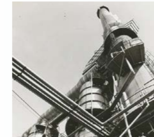
排煙脱硫装置
