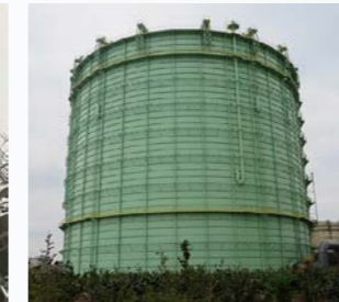
ガスホルダ 耐震性に優れたドライシール型
