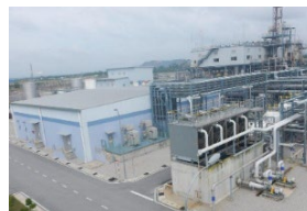
海外大型プラント (マレーシア)
