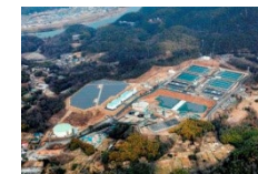
愛知県内2浄水場 排水処理PFI事業
