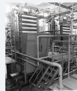
堅型フィルタプレス 汚泥の含水率を大幅低減し全国の上水道施設で活躍
