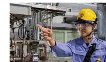
スマートグラスを活用した現場点検
