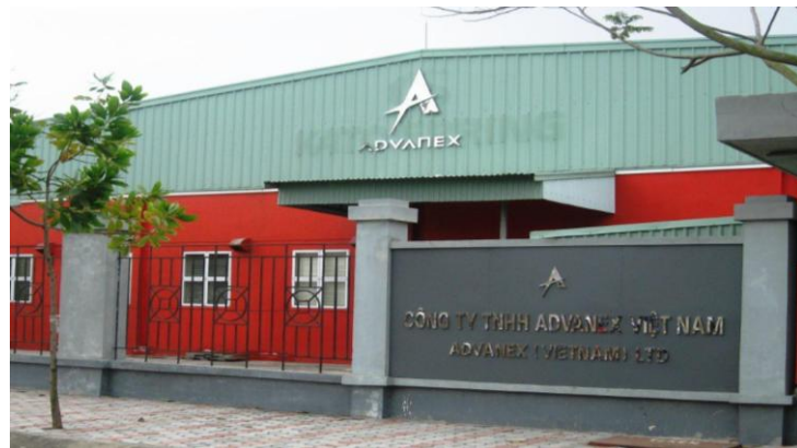
ベトナム第1工場（2006年6月開設）
