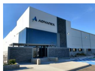
メキシコテラト工場
