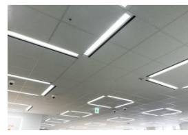
インフラ (天井落下防止など)
