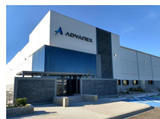
メキシコテラト工場
