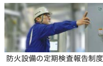
防火設備の定期検査報告制度
