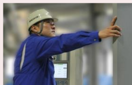
防火設備の定期検査
