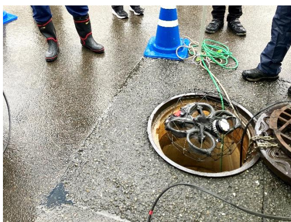
雨天時の雨水管内でも 安定した飛行性能を確認した ELIOS 3
