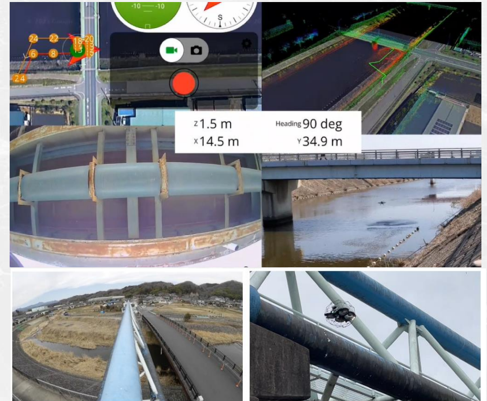
フソウとの水管橋点検の様子
