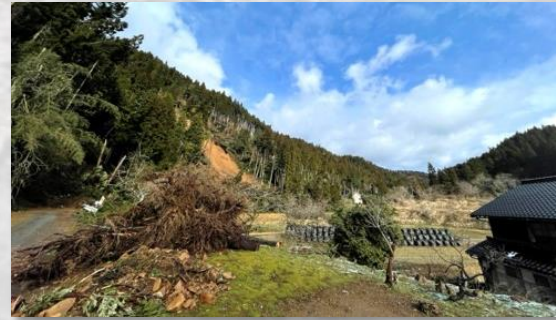
道路寸断の状況確認
