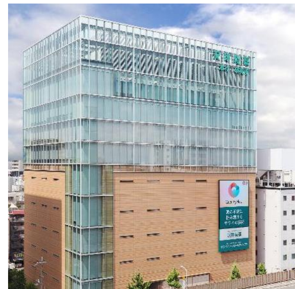
大阪市淀川区：本社ビル外観
