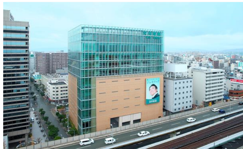
本社ビル外観
