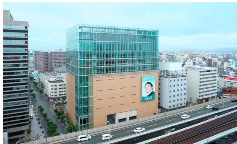
大阪市淀川区：本社ビル外観
