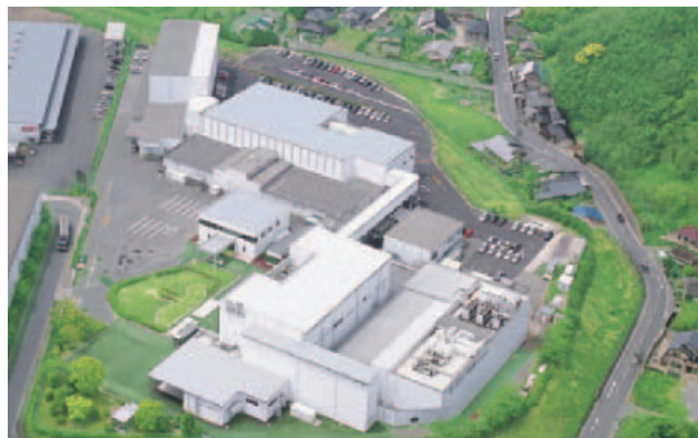
メディサ新薬株式会社 九州工場(敷地面積 34,105㎡)
