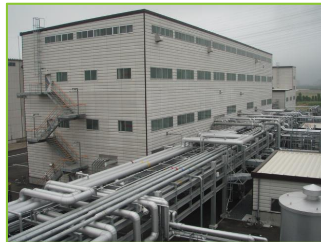
増設中のPPS樹脂工場(茨城県)
