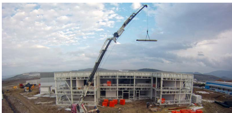
建設中の印刷インキ新工場(トルコ)
