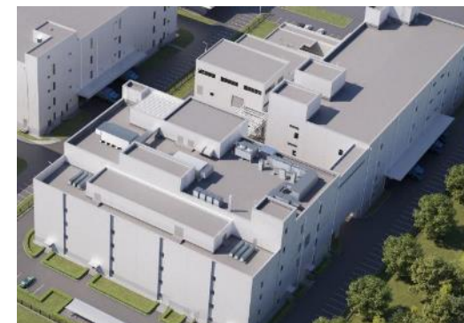
天津工場 3期製造棟 (工キス粉末製造)
