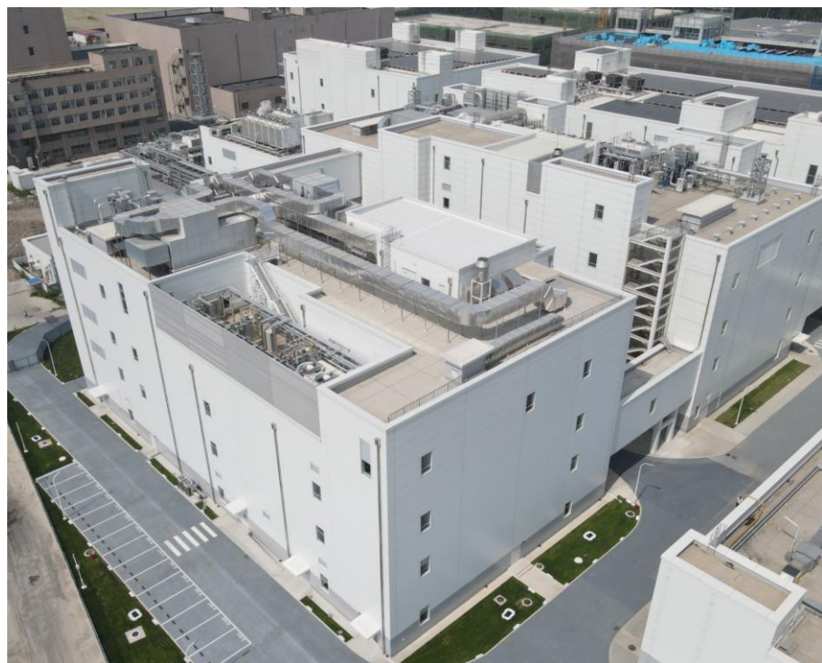
新設した天津工場
