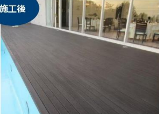
色褪せたガーデンデッキを塗装修繕
