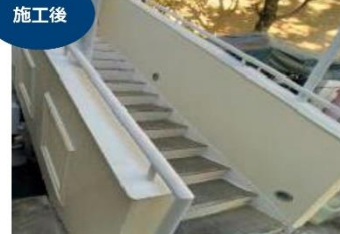
外壁、階段等の塗装修繕
