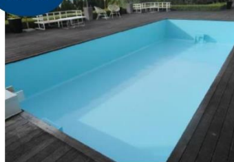
プール内面のコーティング、塗装修繕
