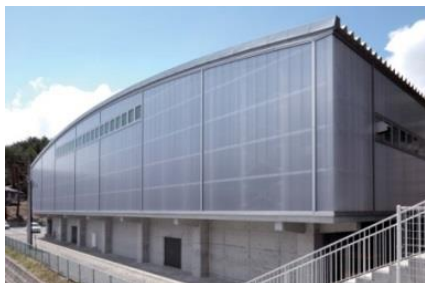
ポリカーボネート樹脂製 高断熱中空パネル「ルメウォール」
