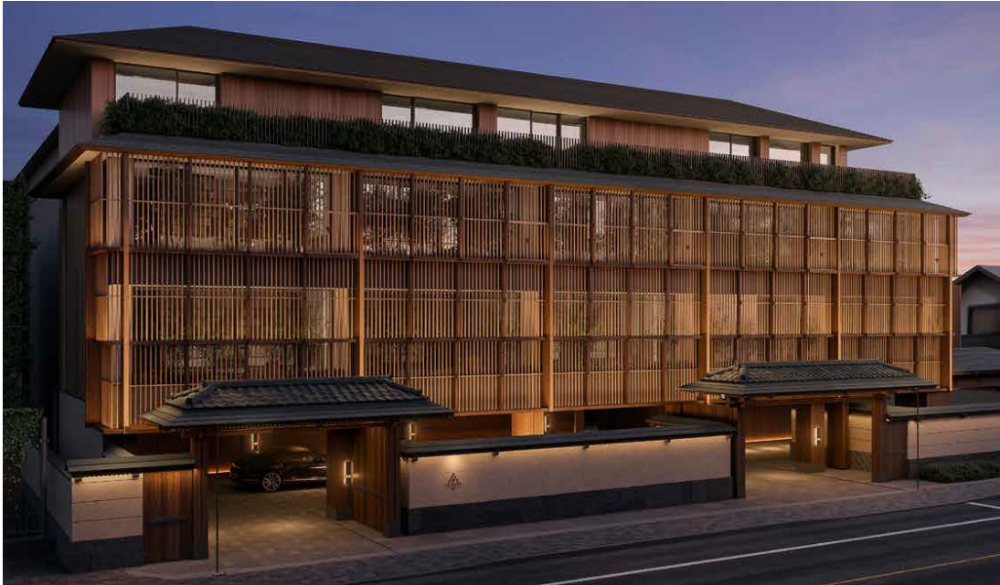
参考画像：「シックスセンス 京都」完成予想外観 CG パース
