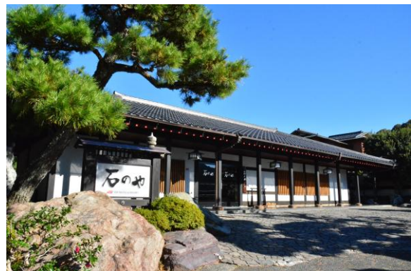
「石のや 伊豆長岡」外観
