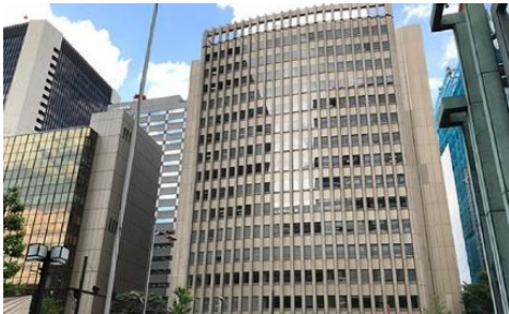
新橋カンファレンスセンター：2,813坪
