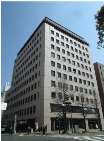
関内新井ビル
