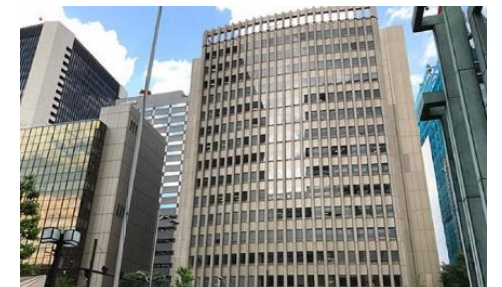
新橋カンファレンスセンター：2,813坪
