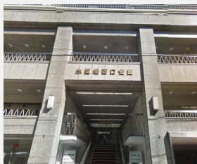
TKPスター貸会議室水道橋 (2019.11～)
