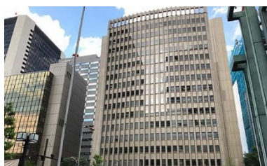
新橋カンファレンスセンター：2,813坪
