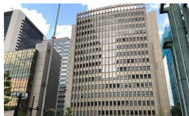
新橋カンファレンスセンター：2,813坪
