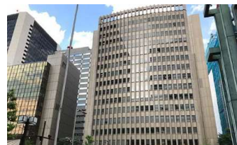
新橋カンファレンスセンター：2,813坪
