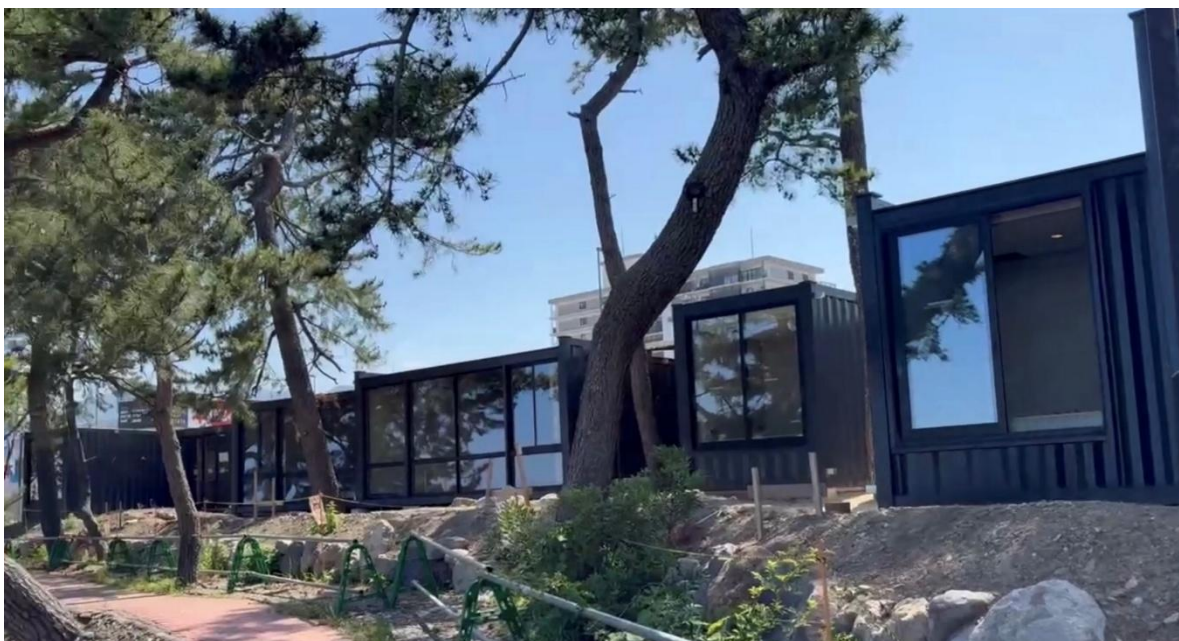
現在建設中の「ISHINOYA 別府」
