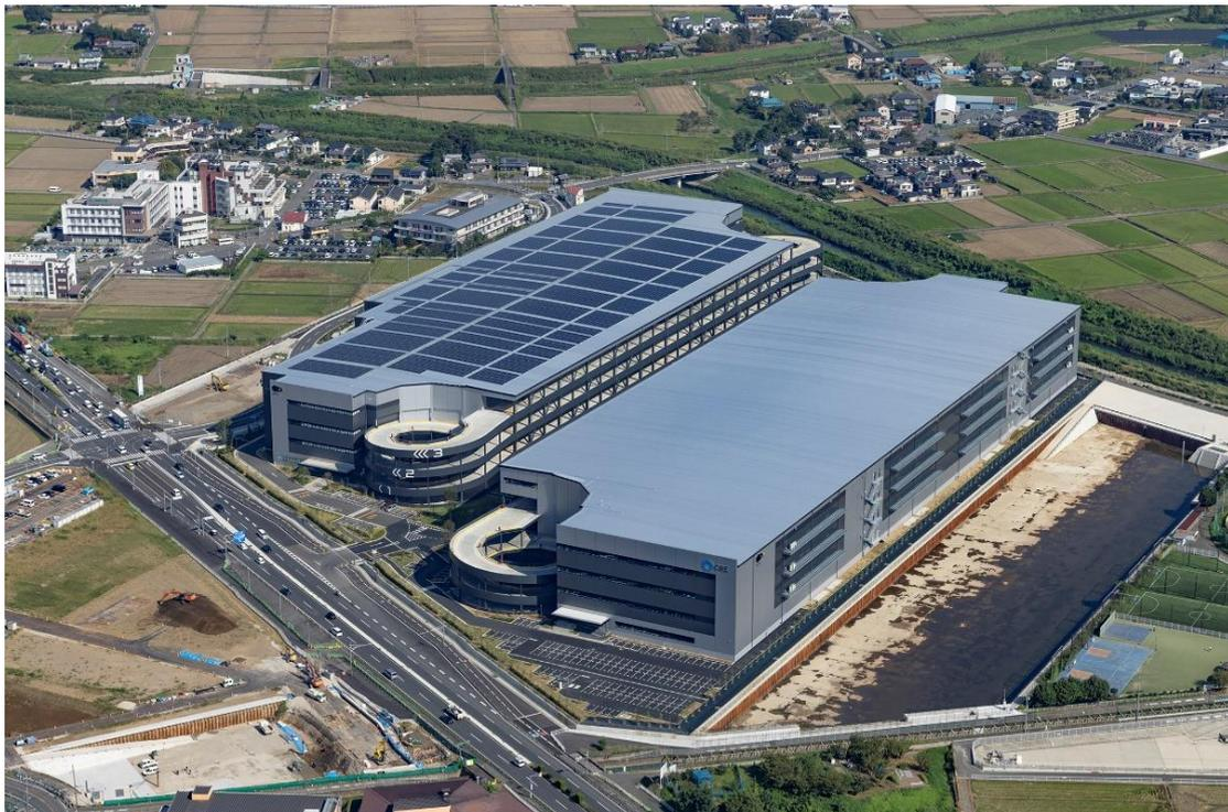
「ロジスクエアふじみ野 B」は、地上 4 階建て、延床面積 114,174.73 m<sup>2</sup> (34,537.85 坪) の物流施設であり、2 階及び 3 階へ大型車両が直接乗り入れ可能なランプウェイを設け、トラックバースを 3 階までの各フロアに備えるマルチテナント対応型の施設です。ランプウェイは上り専用と下り専用をそれぞれ設置するダブルランプウェイ方式として、車両動線を一方通行とすることで場内の安全性向上を図り、トラックバースは計 134 台の大型車が同時接車可能となっております。
