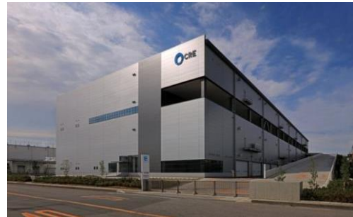
4 ロジスクエア久喜 2016年6月竣工
