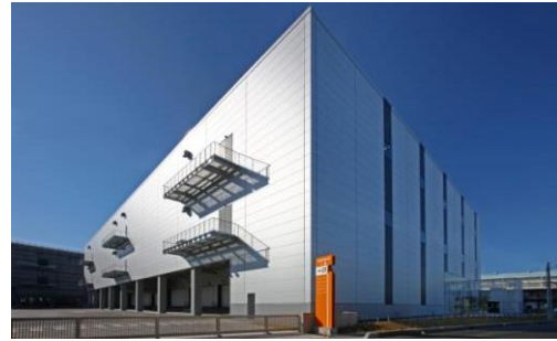
2 ロジスクエア八潮 2014年1月竣工
