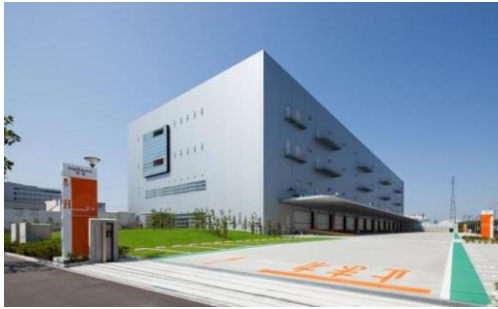
1 ロジスクエア草加 2013年6月竣工
