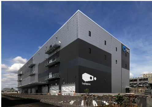
25 ロジスクエア松戸 2023年5月竣工
