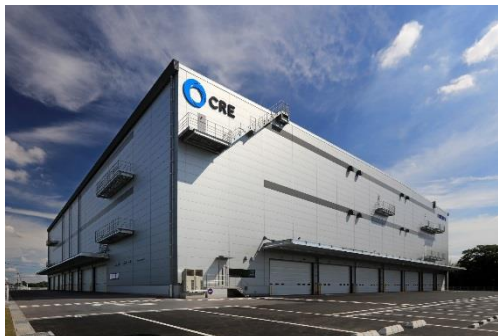
13 ロジスクエア春日部 2018年6月竣工
