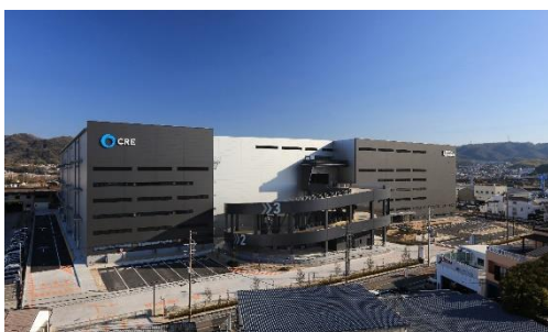
19 ロジスクエア大阪交野 2021年1月竣工
