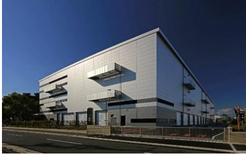
21 ロジスクエア伊丹 2022年11月竣工
