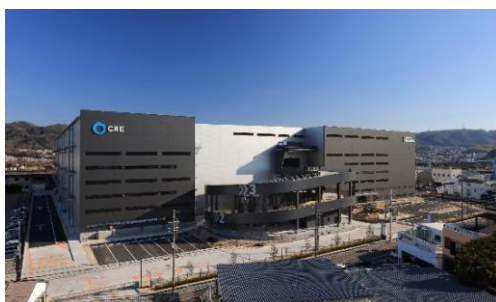
19 ロジスクエア大阪交野 2021 年 1 月竣工
