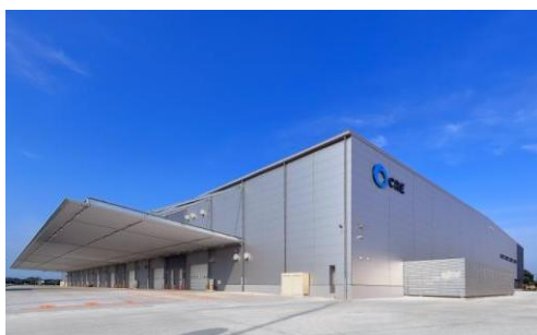
5 ロジスクエア羽生 2016年7月竣工
