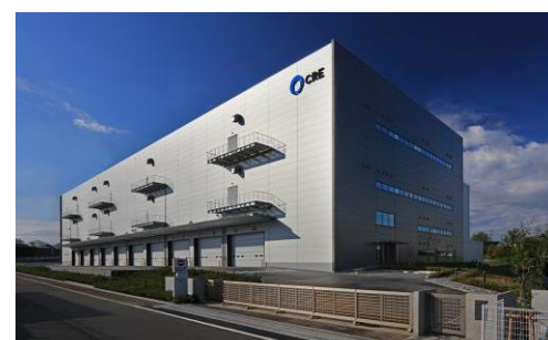
8 ロジスクエア新座 2017年4月竣工
