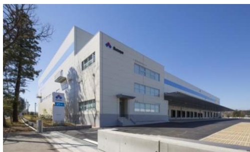
3 ロジスクエア日高 2015年3月竣工
