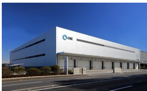
6 ロジスクエア久喜Ⅱ 2017年2月竣工
