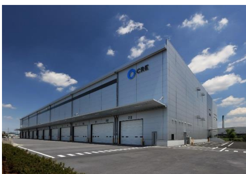
15 ロジスクエア川越Ⅱ 2019 年 6 月竣工
