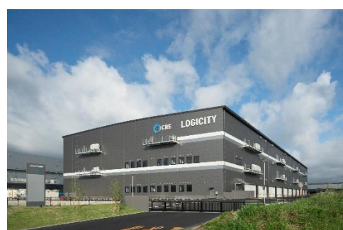
32 ロジシティ小郡 2024 年 7 月竣工
