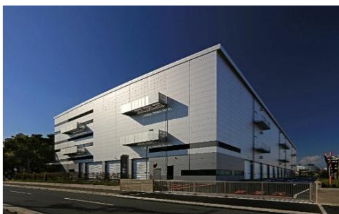
21 ロジスクエア伊丹 2022 年 11 月竣工
