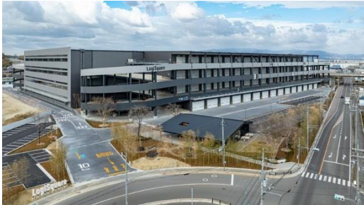
35 ロジスクエア京田辺 A 2025 年 2 月竣工
