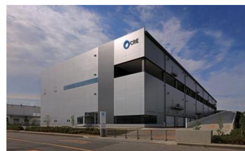
4 ロジスクエア久喜 2016年6月竣工
