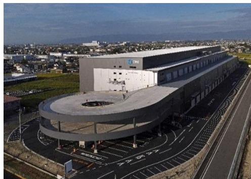
26 ロジスクエア一宮 2023年9月竣工
