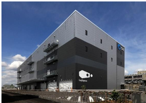
25 ロジスクエア松戸 2023年5月竣工
