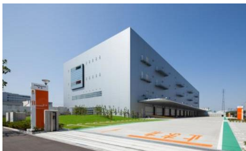
1 ロジスクエア草加 2013年6月竣工
