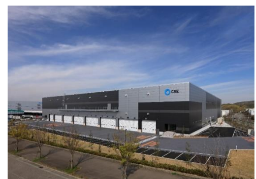
16 ロジスクエア神戸西 2020年4月竣工
