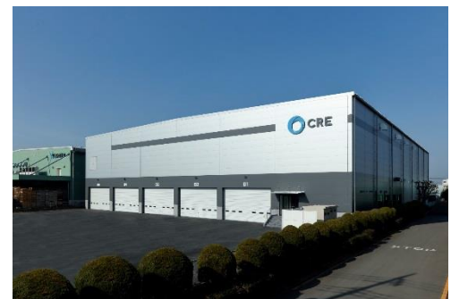
12 ロジスクエア川越 2018年2月竣工
