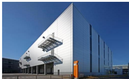
2 ロジスクエア八潮 2014年1月竣工
