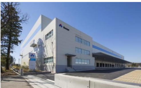
3 ロジスクエア日高 2015年3月竣工
