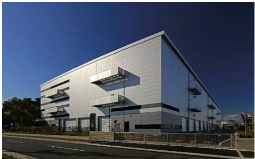
21 ロジスクエア伊丹 2022年11月竣工
