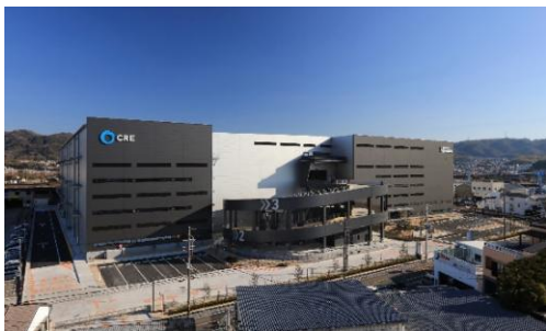
19 ロジスクエア大阪交野 2021年1月竣工
