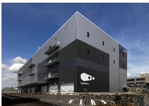
25 ロジスクエア松戸 2023年5月竣工
