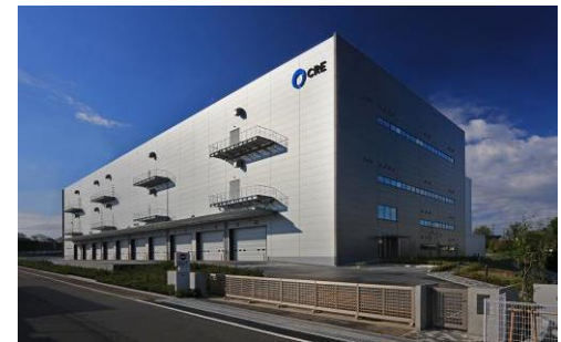
8 ロジスクエア新座 2017年4月竣工
