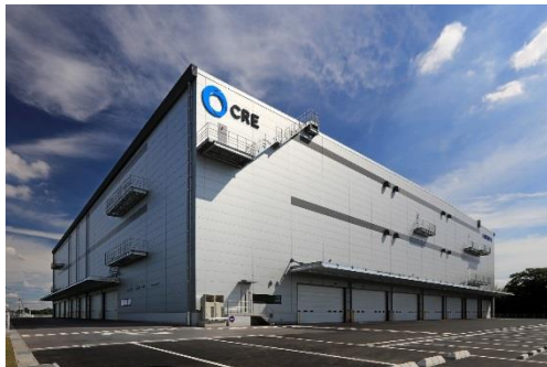
13 ロジスクエア春日部 2018年6月竣工
