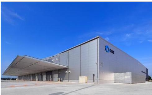
5 ロジスクエア羽生 2016年7月竣工
