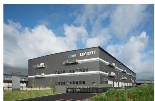
32 ロジシティ小郡 2024年7月竣工
