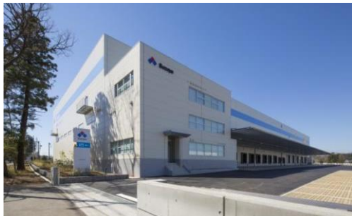
3 ロジスクエア日高 2015年3月竣工
