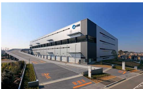
7 ロジスクエア浦和美園 2017年4月竣工
