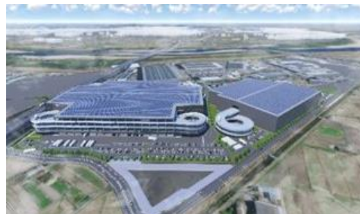
36 ロジスクエア京田辺 A 2025 年 2 月竣工予定 37 ロジスクエア京田辺 B 2026 年竣工予定
