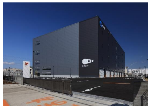
24 ロジスクエア厚木 I 2023年3月竣工
