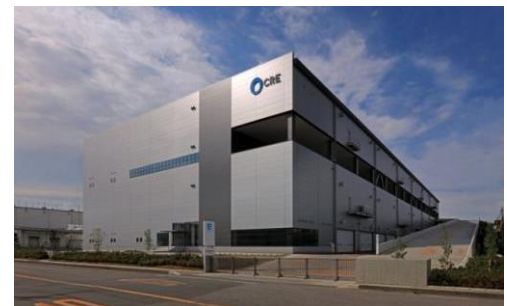
4 ロジスクエア久喜 2016年6月竣工
