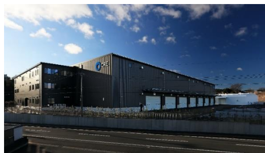
28 ロジスクエア掛川 2024年1月竣工
