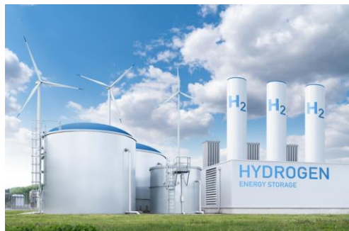
水素製造工場
