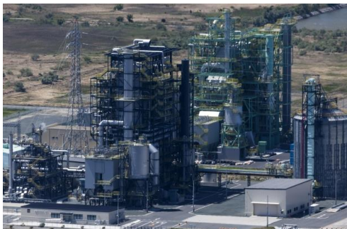
バイオマス発電所
