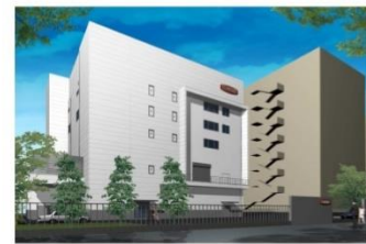
東京工場 新棟 (2021年6月完成予定)
