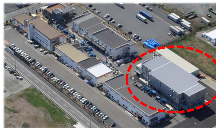
(北九州工場 E棟 (2019年2月竣工))
