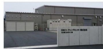
<JCC 名古屋工場 第1工場>
