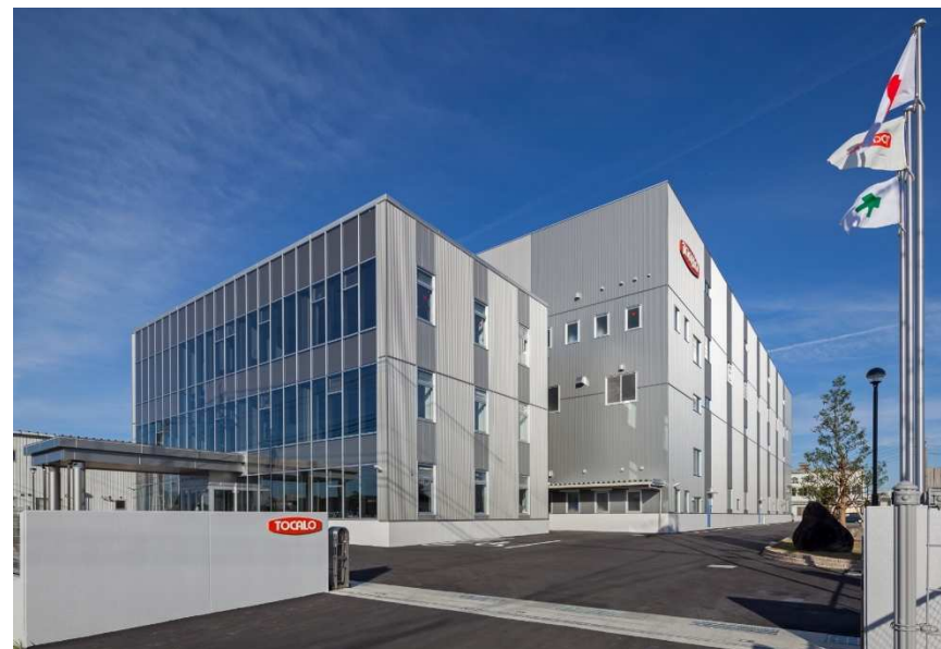
新設された名古屋工場
