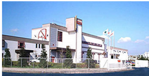
増強工事の完成した小倉第二工場
