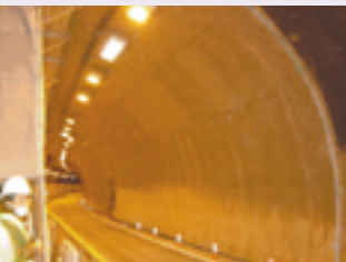
トンネルでの高靱性ボードの使用
