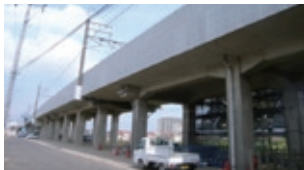
鉄道高架橋高欄の補修例
