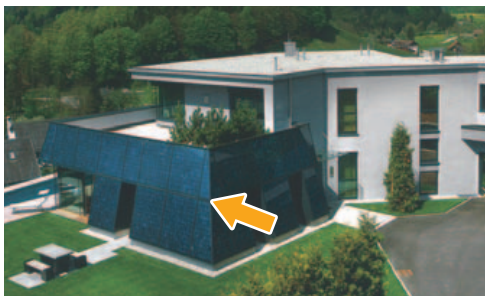
写真提供 ERTEX SOLAR GmbH 太陽電池施工住宅
