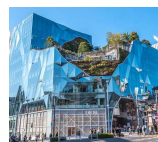
東金プラザ原宿「ハラカド」 渋谷区 商業/公共公益施設
