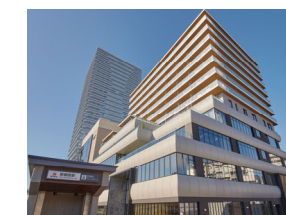
グランクレール綱島
