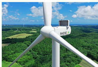
リエネ六ヶ所村千歳風力発電所
