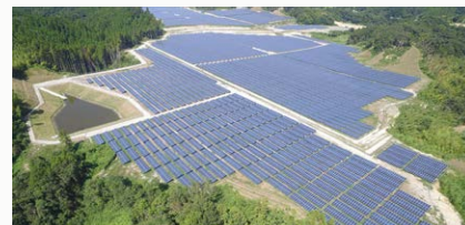
リエネ長南太陽光発電所（千葉県） 定格容量：24MW
